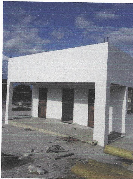
FOTO 15 - KIT ESQUADRIAS E APLICAÇÃO E LIXAMENTO DE MASSA
