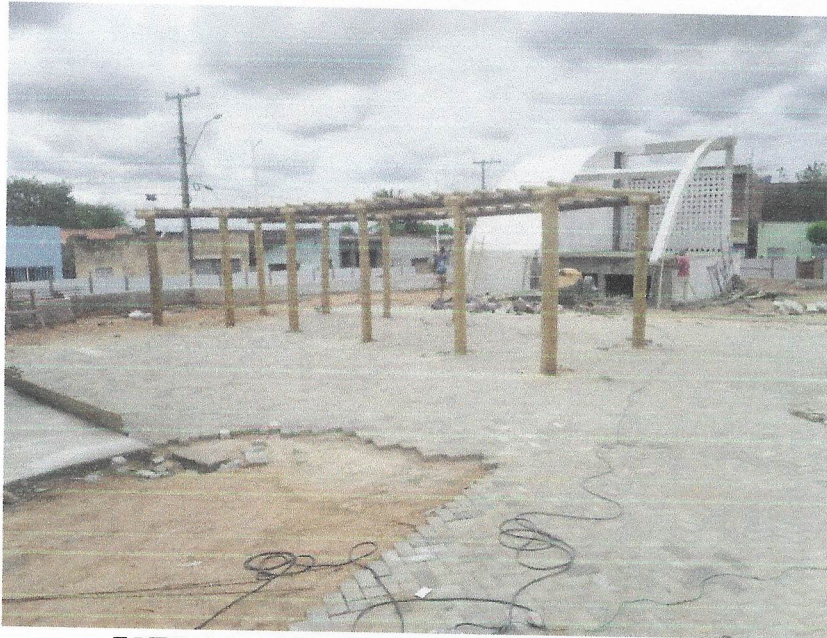
FOTO 14 - PERGOLADO E INTERTRAVADO
