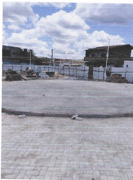
FOTO 13 - POSTE DE ILUMINAÇÃO E CONCRETAGEM
