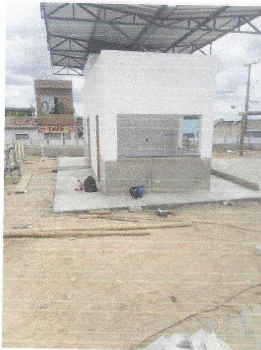
FOTO 7 - COBERTURA E EMASSAMENTO
